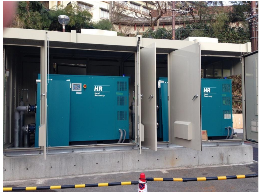
災害に備えて稼働した温泉バイナリー発電施設＝兵庫県新温泉町湯
